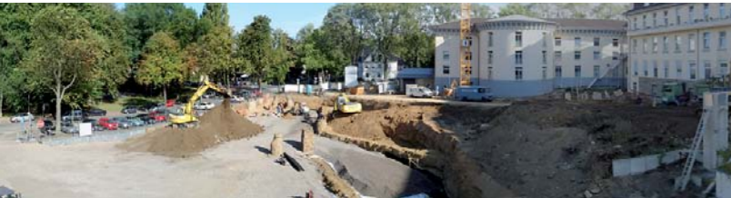
Baustelle JosefCarree: Stand 37. KW 08
